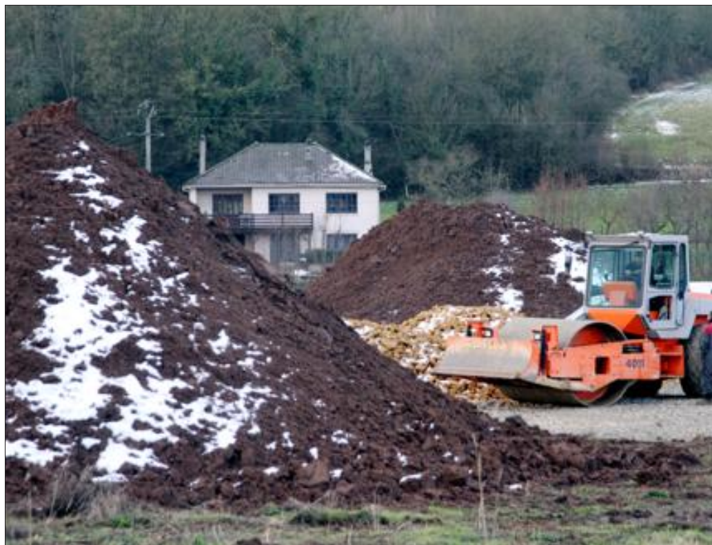
Les travaux de terrassements ont débuté début décembre, juste à côté de l'actuelle Magnascole.
